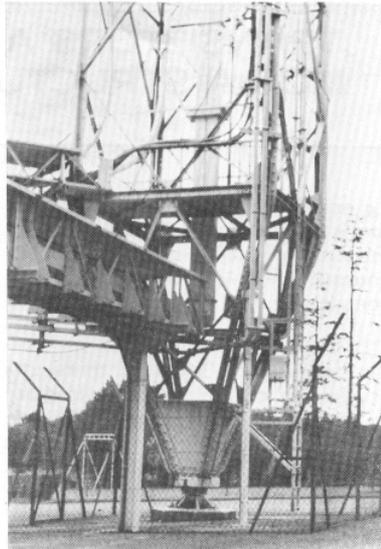
Photo 12. — Base du pylône du centre émetteur de Rennes-Saint-Pern supportant les antennes émissions. Au centre du pylône, on remarquera le guide d'onde UHF qui monte vers les antennes UHF situées en haut du pylône.
