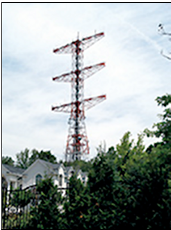
En 1937, Armstrong finança la construction de la première station radio FM au monde, dans les environs d'Alpine, New Jersey, États-Unis. Diffusé sur 42,8 MHz sous l'indicatif W2XMN, le signal pouvait être entendu clairement jusqu'à 160 km (100 miles). Aujourd'hui, le pylône de 122 mètres de haut reçoit et relaie des signaux de télévision, cellulaires et hyperfréquences, et est utilisé par la station FM d'une université. Photo DR
